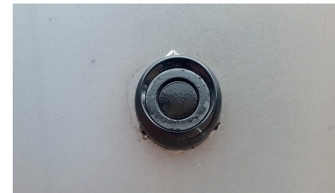
Montaż równy z powierzchnią zespołu czujnika/tulei do powierzchni pionowej.
